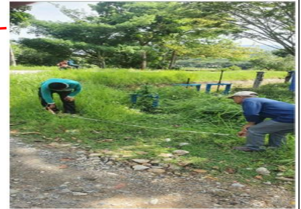
Lokasi Pemasangan Pipa Jalur JDU ND. 200 mm ( Jln. Kabupaten Bukit Hijau dan Pekantoran Desa Babah Lhueng )
