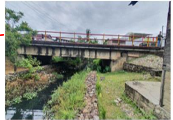
Lokasi Pemasangan Pipa Jalur JDU ND. 200 mm ( Jln. Nasional Pulau Kayu Desa Pa
