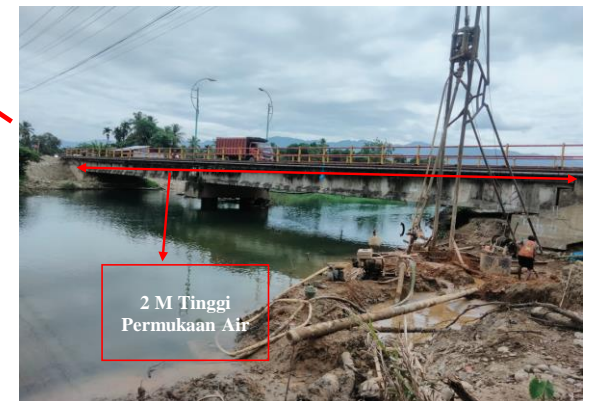
Lokasi Pemasangan Pipa Jalur JDU ND. 200 mm ( Jln. Nasional Tapak Tuan - Meulaboh Desa Geulima Jaya )
