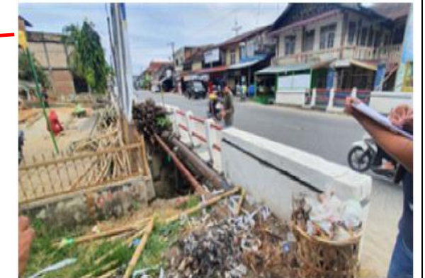
Lokasi Pemasangan Pipa Jalur JDU ND. 200 mm ( Jln. Nasional Persada Desa Kedu Siblah )
