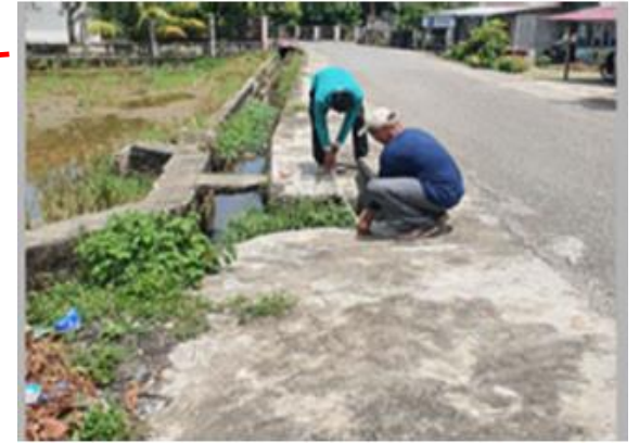
Lokasi Pemasangan Pipa Jalur JDU ND. 200 mm ( Jln. Kabupaten Padang Hilir- Meunasah Desa Kepala Bandar )
