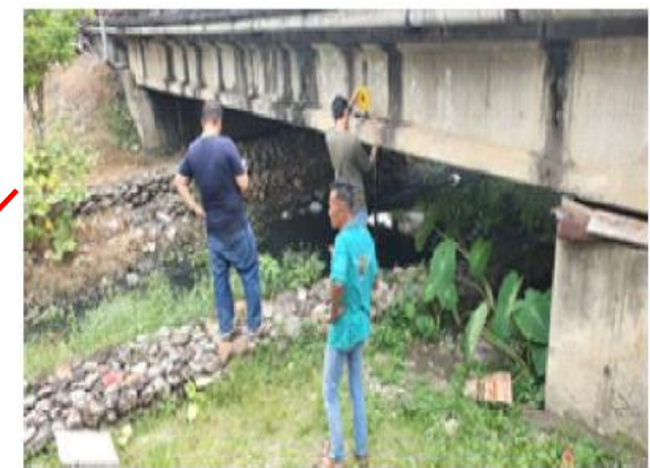
Lokasi Pemasangan Pipa Jalur JDU ND. 200 mm ( Jln. Nasional Tapak Tuan - Meulaboh Desa Geulima Jaya )
